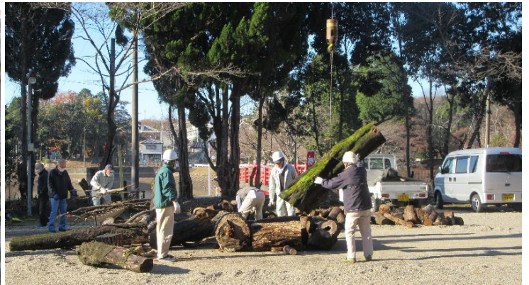
クレーンを使用して篝火を組上げ
