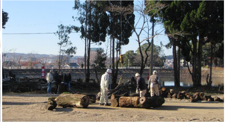
クレーンを使用して篝火の組上げ開始
