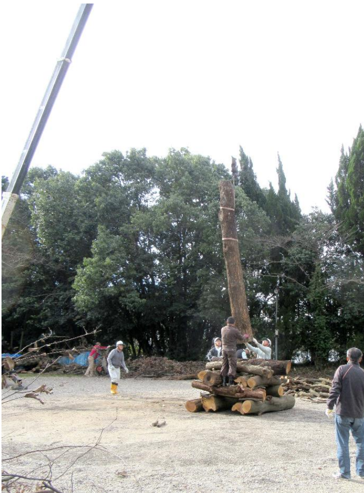
クレーンを使用して篝火を組上げ
