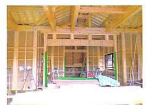
社殿内部工事
