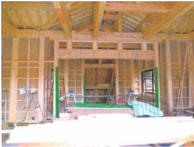
社殿内部工事
