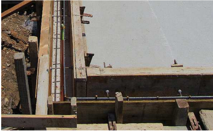
④基礎の上にさらに鉄筋を入れる(5月22日)
