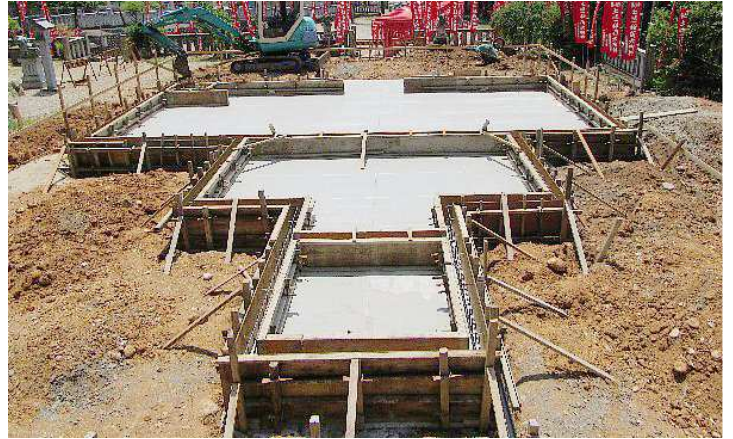
④基礎の下部分が完成 (5月22日午後)
