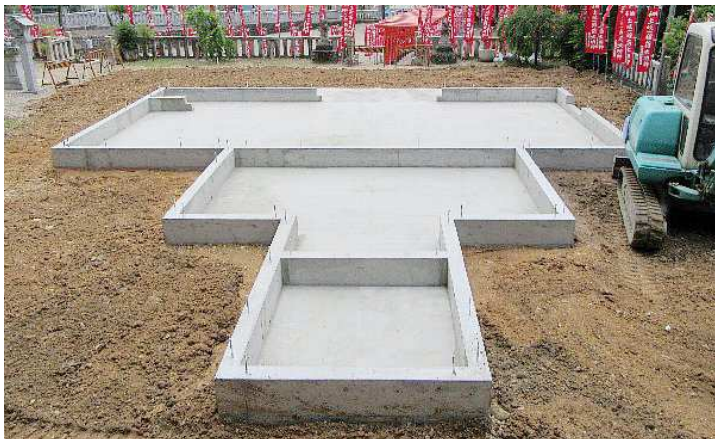
⑥枠を外して基礎完成 (5月26日)
