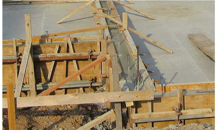
⑤ボルトを入れてコンクリートで固める (5月23日)
