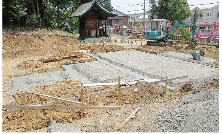
②べた基礎の基礎部分完成 (5月14日)
