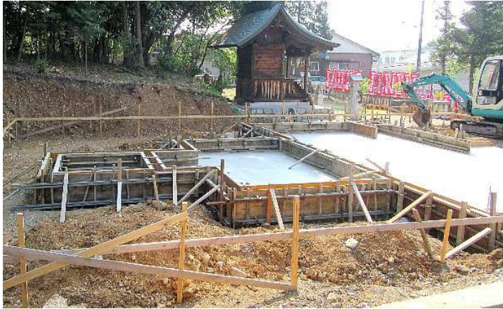
③基礎の下部分 (5月22日午前)
