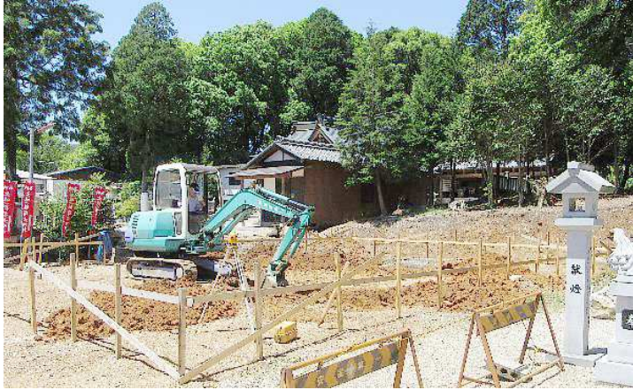
①基礎工事開始 (5月12日)
