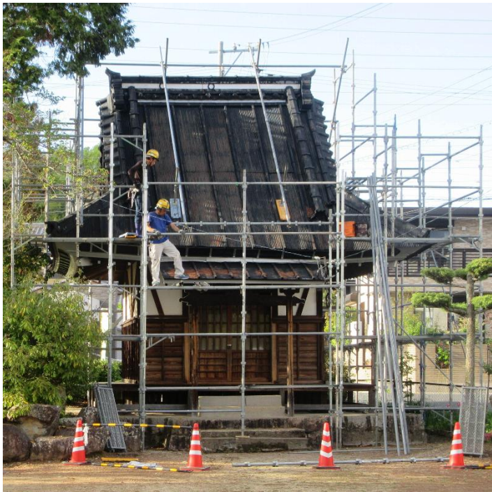
精抜きし、後日作業開始 (4月26日)
