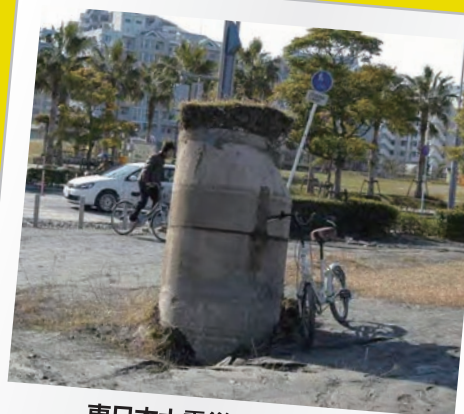
東日本大震災 液状化被害 ～せり上がるマンホール～(千葉県浦安市) 【浦安市提供】
