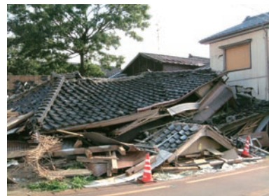
【新潟県中越沖地震 建物被害】
